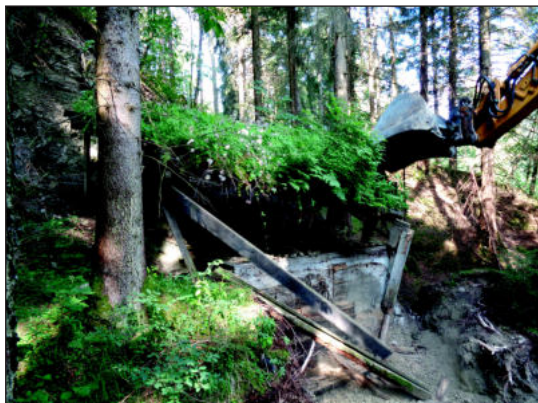
Abriss der Anzeigedeckung
